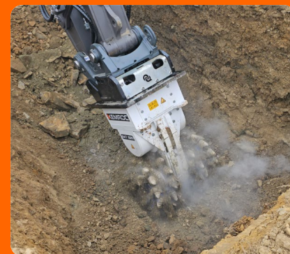
Die Querschneidkopffräse im Einsatz. Mit diesem Anbaugerät am Großbagger wurden große Mengen an festem Dolomitgestein im Untergrund gelöst.
