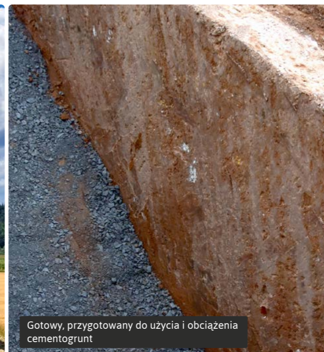
KSI 12000 | Wykonywanie ściany
