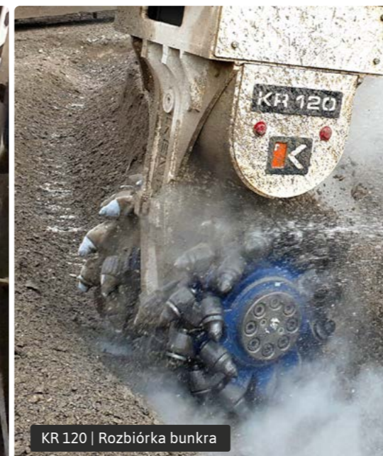
Specjalna obudowa z osłoną przewodów hydraulicznych
