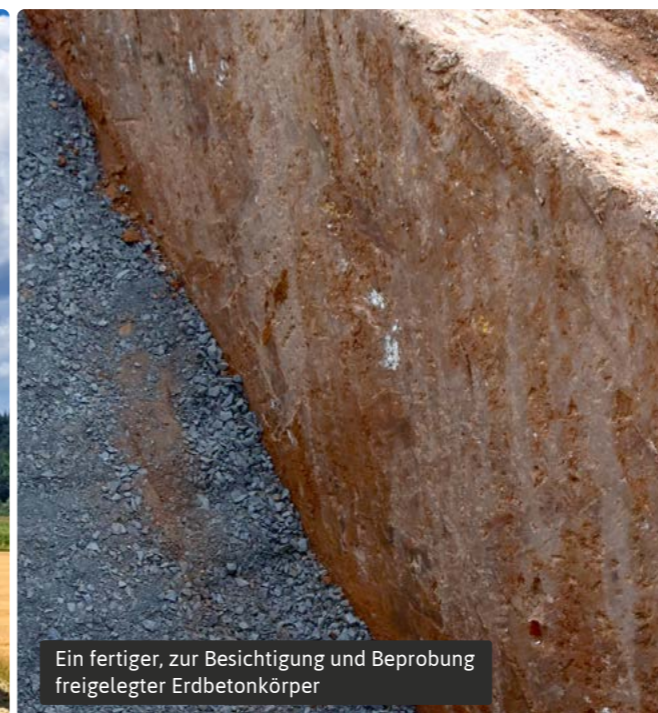
KSI 12000 | Dichtwand erstellen
