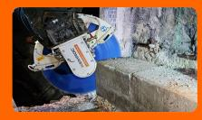
Ein Schnitt durch den Kabelkanal – mit wenig Staub dank Wasserbedüsung. Danach wird das freigelegte Betonstück losgestemmt und zum Abtransport verladen.
