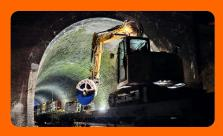
Ein 8-t-Bagger mit einer Diamantsäge KDS 30 fährt auf einem Plattformwagen in den Elleringhauser Tunnel ein. Seine Aufgabe bestand darin, Beton-Kabelkanäle am Tunnelfuß zu zerschneiden.
