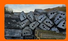
Die herausgeschnittenen Einzelstücke der Kabelkanäle wurden aus dem Tunnel befördert und sind bereit für die Wiederaufarbeitung des Baustoffs Beton.
