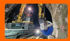
Der Maschinist stellt den Bagger quer zur Tunnelrichtung auf und positioniert in Abständen von 150 cm die KEMROC-Diamantsäge auf dem Kabelkanal.
