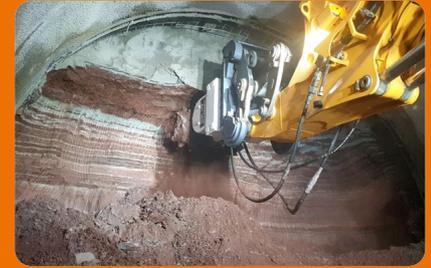
Die KEMROC-Spezialfräse KR 165 beim Einsatz an der Ortsbrust. Die Bagger-Fräsen-Kombination erwies sich als ein leistungsfähiges Vortriebssystem.
