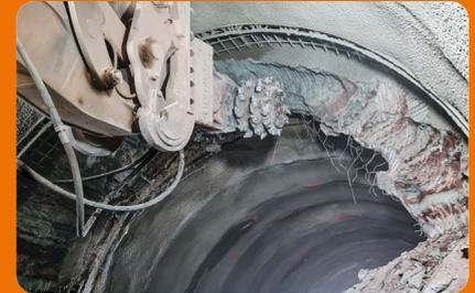
Als eine schlüssige Bagger-Fräsen-Kombination erwies sich eine Querschneidkopfräse KEMROC KR 165 an einem speziellen schweren Liebherr-Tunnelbagger.
